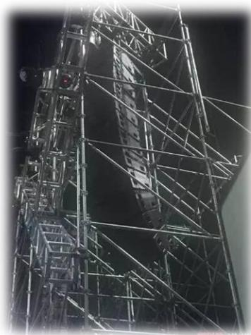
主扩音箱采用了 L-Acoustics V-DOSC 双十五寸线阵列音箱搭配 L-Acoustics dV-DOSC 双八寸线阵列音箱组成，每组 15+3 组成，舞台两侧各一组；侧面补声音箱采用 L-Acoustics KUDO 双十二寸线阵列音箱，每组 12 只组成，舞台两侧各一组
